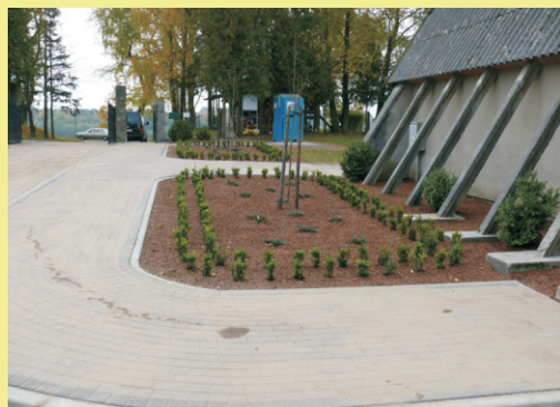
Alejki na cmentarzu komunalnym po remoncie
