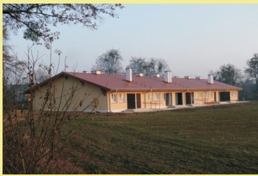
Nowo wybudowany budynek mieszkalny w Anglitych
