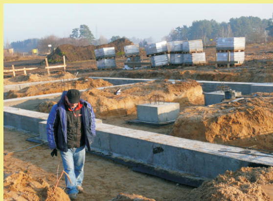
Stacja przeładunkowa odpadów w budowie
