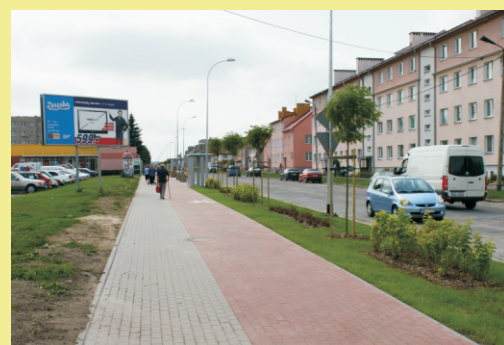
Chodnik przy ulicy Ogrodowej po remoncie
