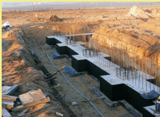
Stacja przeładunkowa odpadów w budowie
