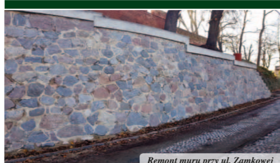
Remont muru przy ul. Zamkowej
