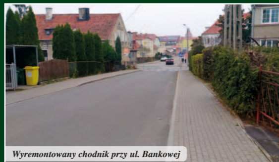
Wyremontowany chodnik przy ul. Bankowej
