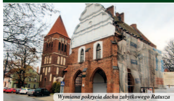
Wymiana pokrycia dachu zabytkowego Ratusza
