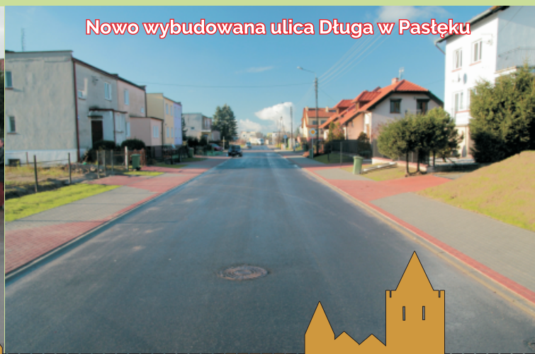
Oficjalne oddanie do użytku nowo wybudowanych ulic: Długiej, Wiosennej, Elbląskiej i Gen. Andersa
