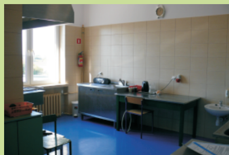
Wyremontowana kuchnia w Szkole Podstawowej w Zielonce Pastęckiej
