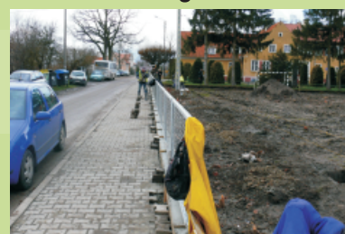
Budowa boiska przy SP w Rogajnach
