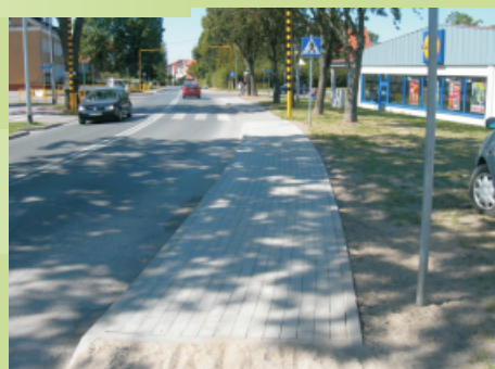
Wyremontowany chodnik przy ulicy Kopernika w Pastęku
