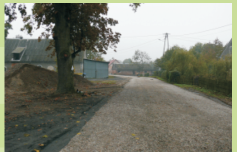
Wyremontowany odcinek gminnej drogi wewnętrznej w miejscowości Anglity
