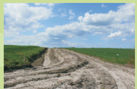
Remont gminnej drogi gruntowej w miejscowości Gulbity
