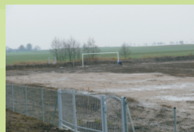
Budowa boiska sportowego w Dargowie
