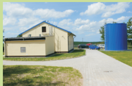
Wyremontowany budynek SUW w Krasinie
