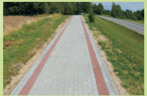
Nowy chodnik prowadzący do cmentarza komunalnego przy ulicy Augustyna Steffena w Pastęku
