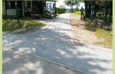
Nowy chodnik prowadzący do cmentarza komunalnego przy ulicy Augustyna Steffena w Pastęku
