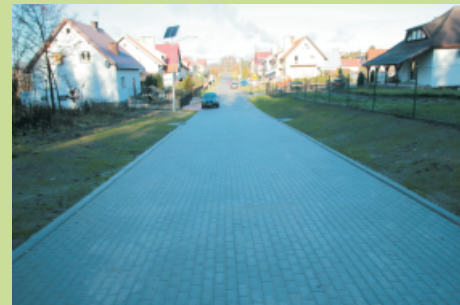
Nowo wybudowana ul. Gen. Andersa w Pastęku
