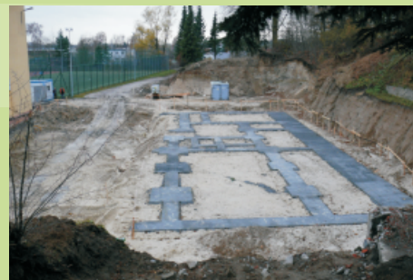
Prace budowlane przy rozbudowie Szkoły Podstawowej Nr 2 w Pastęku
