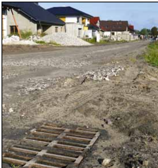
Sieć burzowa ul. Kolonia Zdroje po zakończeniu inwestycji.
