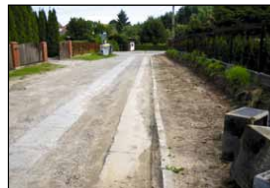
Przebudowa ul. Rzemieśniczej.
