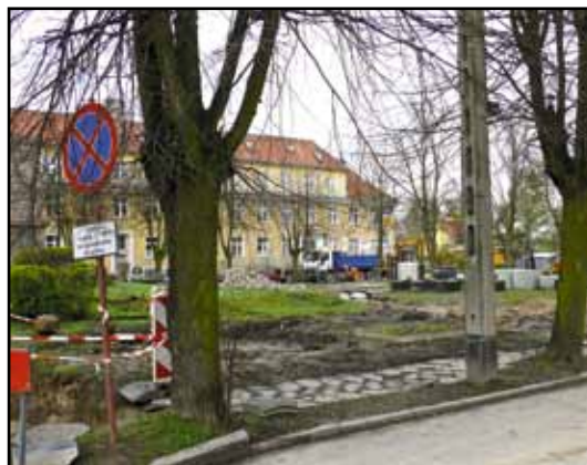
Pl. Grunwaldzki w trakcie robót.
