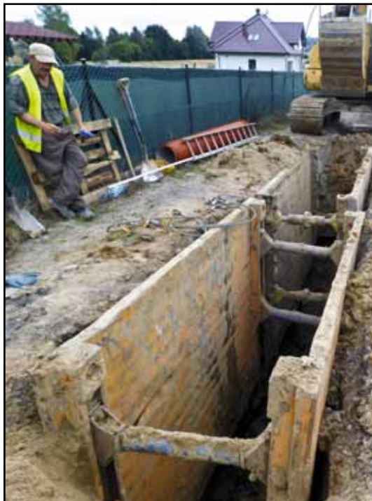
Sieć burzowa ul. Kolonia Zdroje w realizacji.
