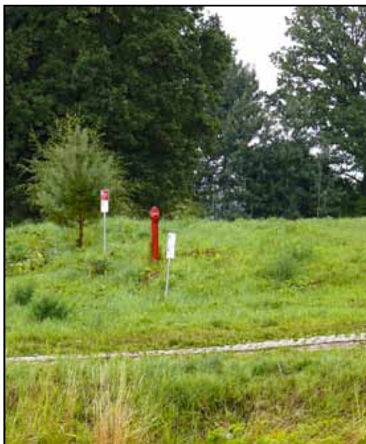
Budowa sieci wodociągowej Krasin - Kanał Elbląski.
