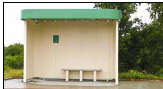
Wiat przystankowa typu ATENA STANDARD w miejscowości Kopina (przy drodze wojewódzkiej nr 513).
