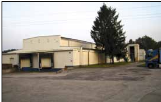
Rozbudowa zakładu przetwórstwa rybnego CDS Europe w Pasłęku przy ulicy Sprzymierzonych.
