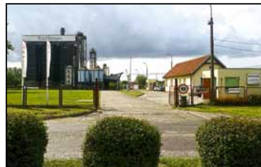
Teren adaptacji zabudowy na potrzeby S-ki Biofeed przy ul. Westerplatte.
