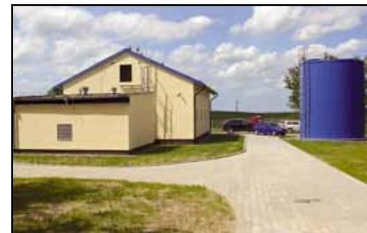
Budynek stacji uzdatniania wody po remoncie.
