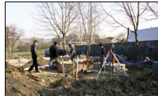
Prace przy studni.
