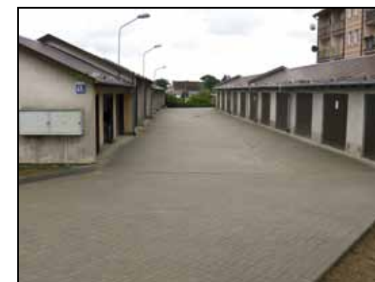
Utwardzenie terenu przy garażach.
