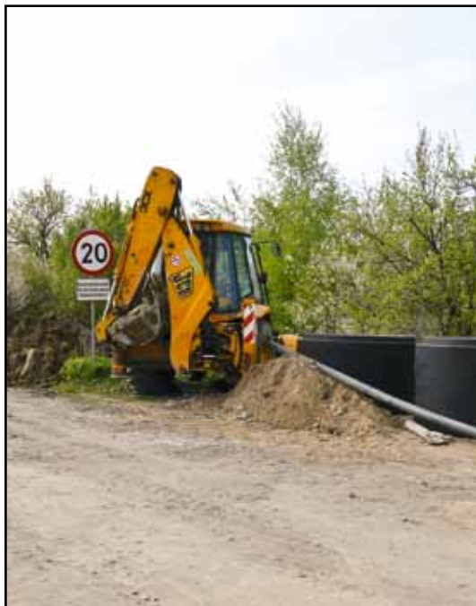
Sieć wodociągowa do ROD w trakcie robót.
