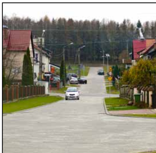
Ul. Gen. Andersa po zakończeniu prac inwestycji.
