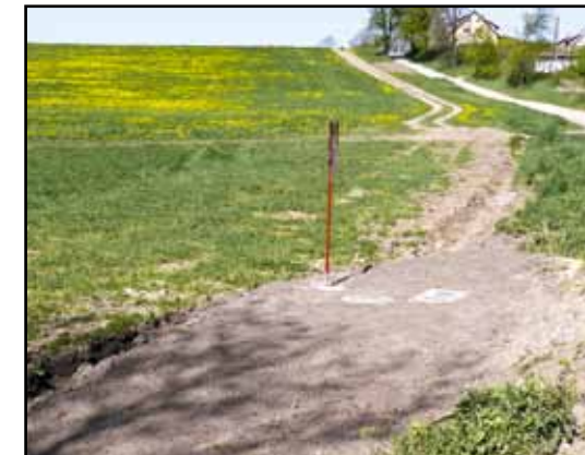
Budowa sieci wodociągowej Rydzówka-Talpity.
