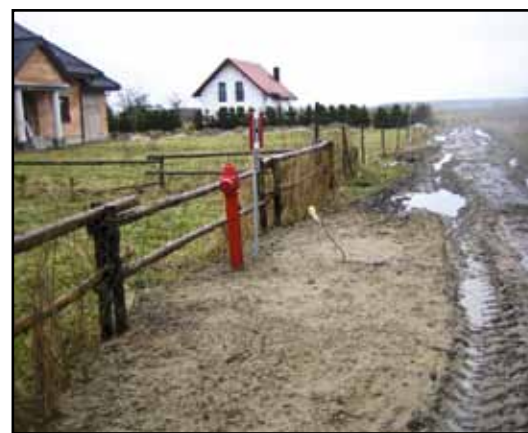
Rozbudowa sieci wodociągowej w Rogajnach.
