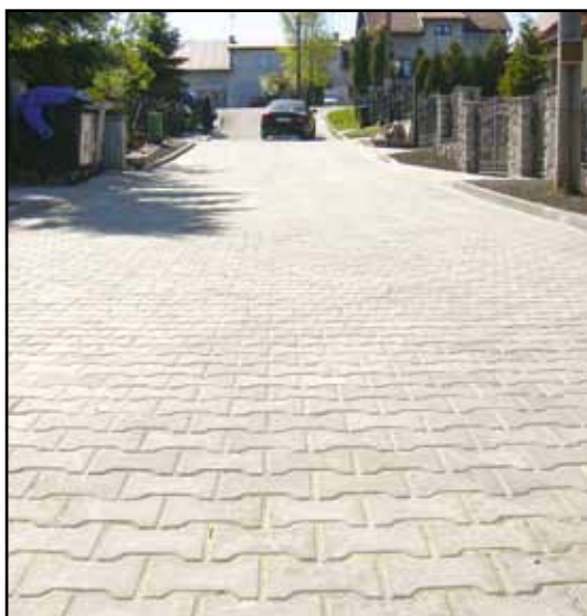
Wyremontowana gminna ulica wewnętrzna przy ul. Konopnickiej w Pasłęku.
