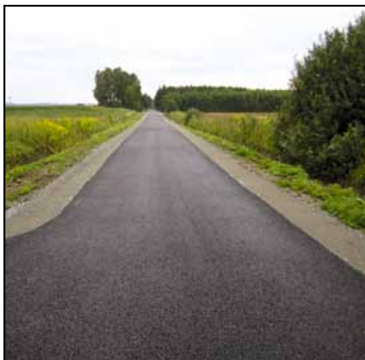
Wykonanie nawierzchni asfaltowej do Kol. Marianka.
