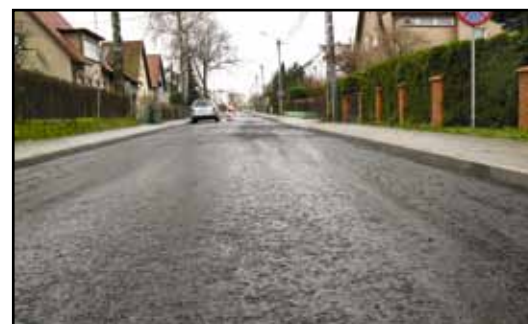
Wyremontowana nawierzchnia powiatowej ulicy Limanowskiego w Pasłęku.
