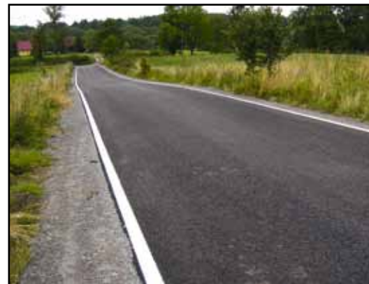
Wyremontowana droga gminna do miejscowości Rzędy.
