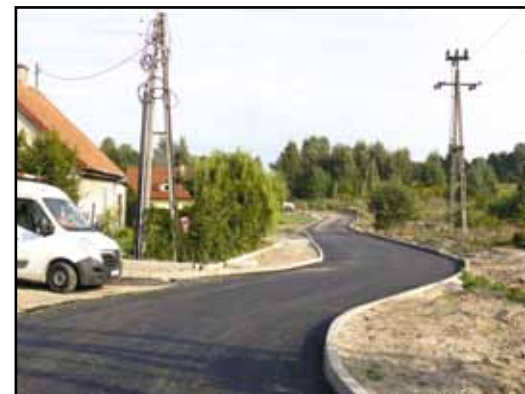
Ul. Lanca w przebudowie.
