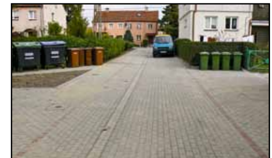
Wyremontowana nawierzchnia gminnej drogi wewnętrznej przy ul. Gdańskiej.
