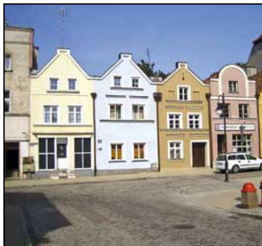
Zabytkowe kamieniczki przy ul. Dąbrowskiego po remoncie.
