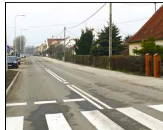
Ul. Polna w Pasłęku po zakończeniu inwestycji.
