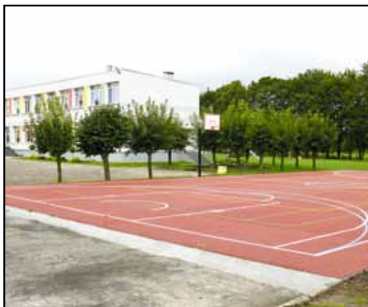
Boisko przy SP w Zielonce Pasłęckiej po zakończeniu robót.
