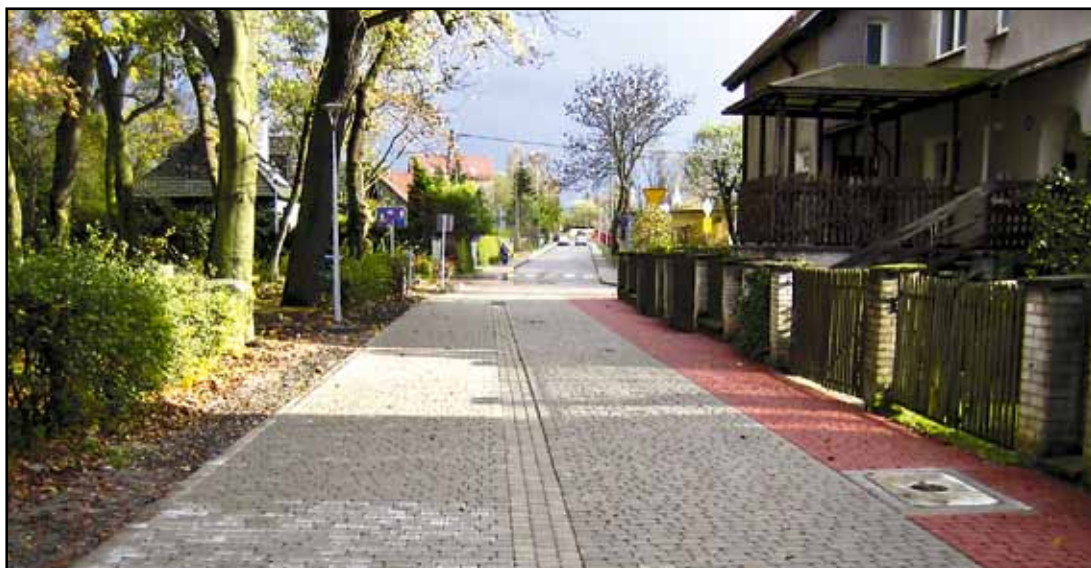
Wyremontowany ciąg pieszo-jezdny.
