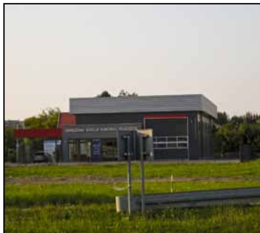
Budowa Stacji Kontroli Pojazdów z Myjnią przy ul Kraszewskiego.
