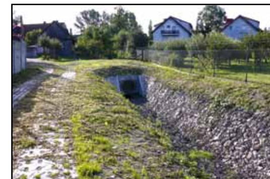
Separator przy ul. Konopnickiej po zakończeniu robót.
