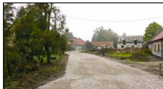
Wyremontowana gminna droga wewnętrzna w miejscowości Anglity.
