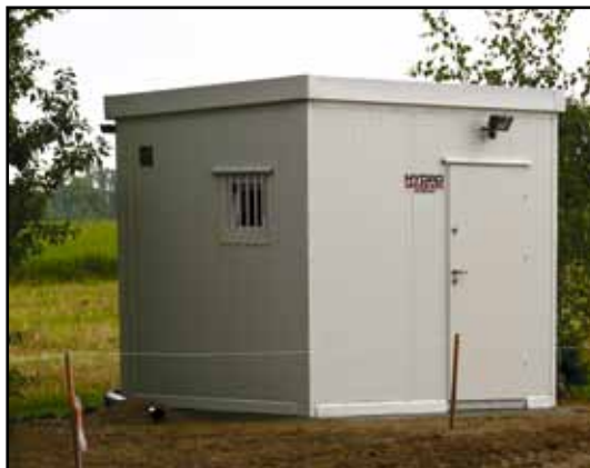
Rozbudowa istniejącej sieci wodociągowej Kolonia Rogajny.
