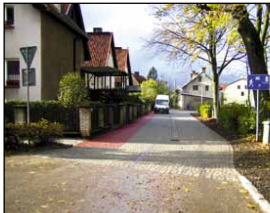
Wyremontowany ciąg pieszo-jezdny.
