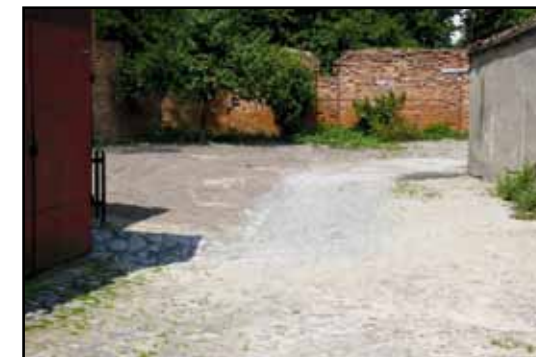
Separator przy ul. Firleja po zakończeniu prac.
