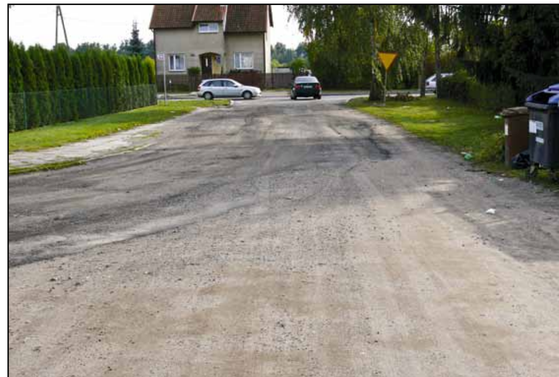
Ul. Wiosenna przed rozpoczęciem prac.
