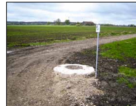
Rozbudowa sieci wodociągowej Kolonia Łukszty.
