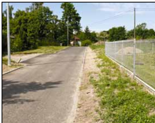
Droga gminna wzdłuż działki nr 78 po zakończeniu inwestycji.
