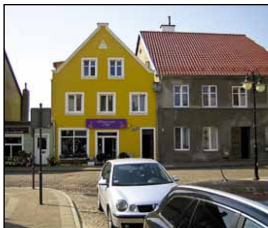
Zabytkowa kamieniczka przy ul. Mickiewicza po remoncie.
