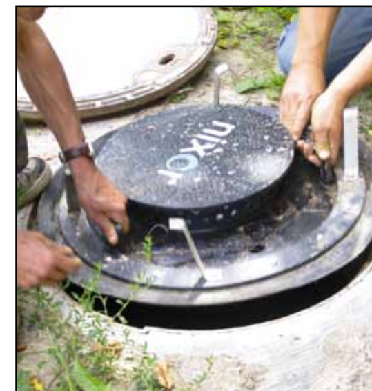
Budowa kanalizacji sanitarnej Rogajny – Gryżyna – Majki, Zielonka Pasłęcka – etap I Pasłek – Gryżyna.
