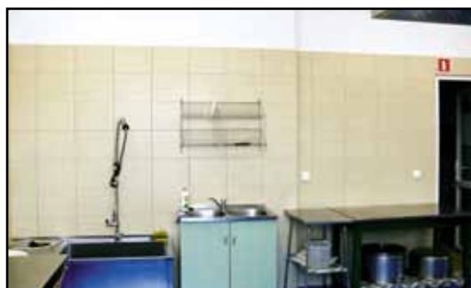
Kuchnia po remoncie.
