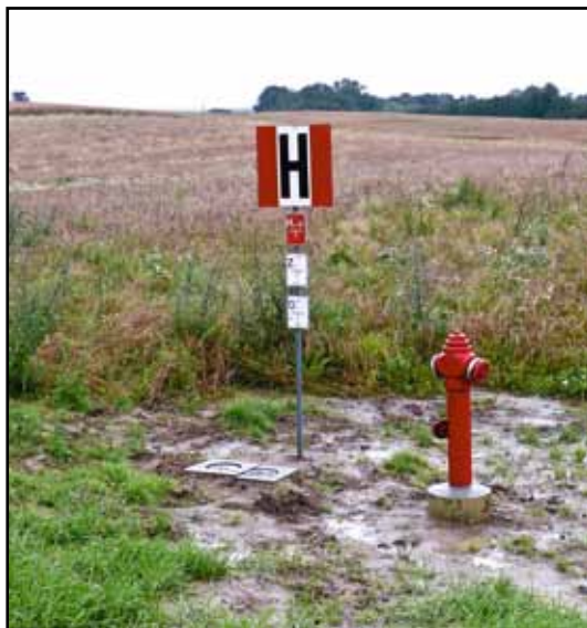
Rozbudowa istniejącej sieci wodociągowej Kolonia Rogajny.
