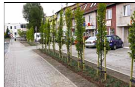
Wyremontowany parking przy ul. Jagiełły.
