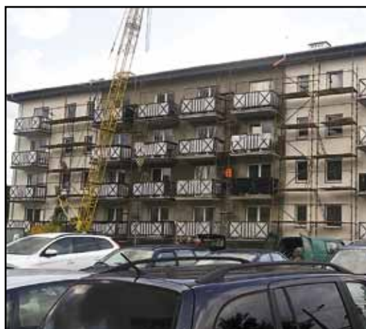
Budowa budynku mieszkaniowego wielorodzinnego przy ul. Dworcowej.
