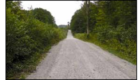
Wyremontowana droga powiatowa nr 1156N do miejscowości Bądy.
