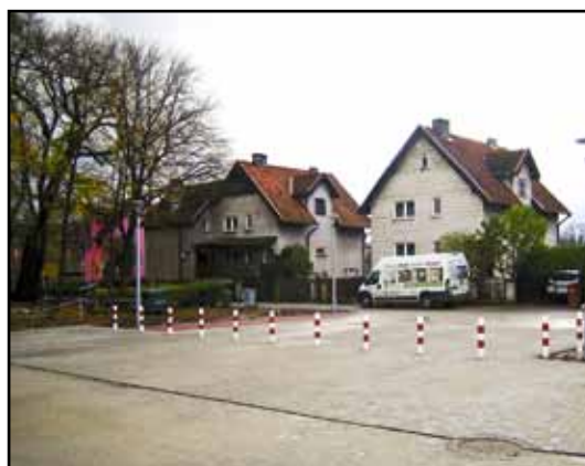
Wyremontowany ciąg pieszo-jezdny.
