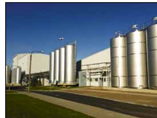
Rozbudowa i unowocześnienie Zakładu ICC Sery przy ul. Dworcowej.
