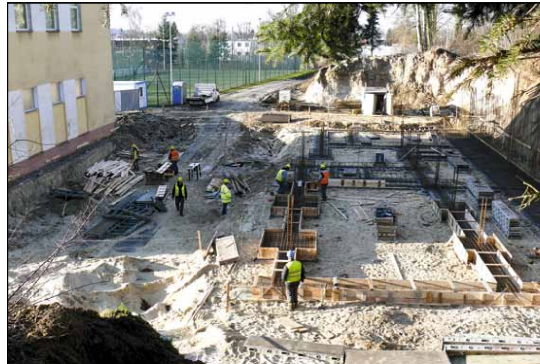
Rozbudowa SP nr 2 w trakcie prac.
