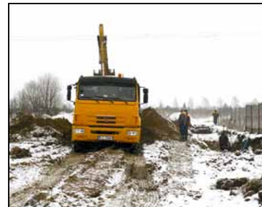
Ul. Firmowa w realizacji.
