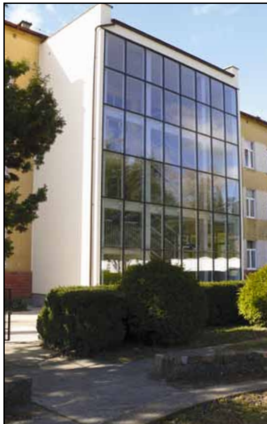
Fragment budynku SP nr 2 w Pasłęku.
