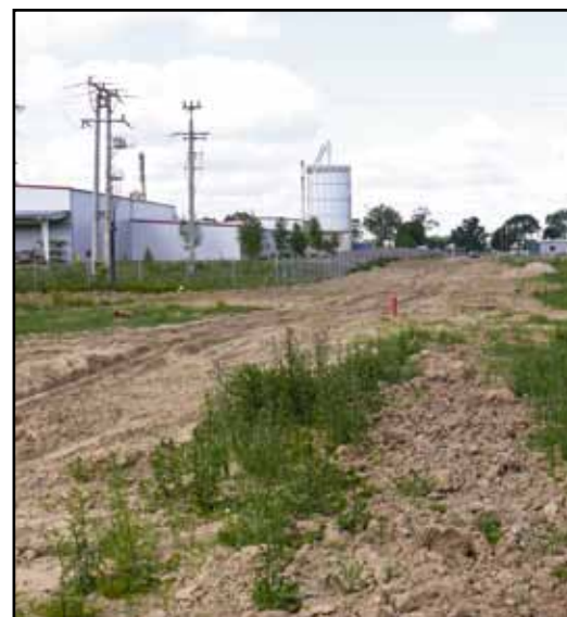
Ul. Firmowa w realizacji.
