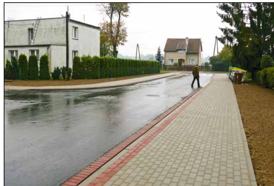
Ul. Wiosenna po zakończeniu inwestycji.
