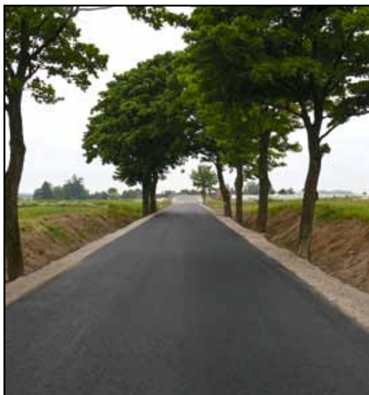
Wyremontowany odcinek drogi powiatowej nr 1179N Sambród – Marzewo o długości 375 metrów.
