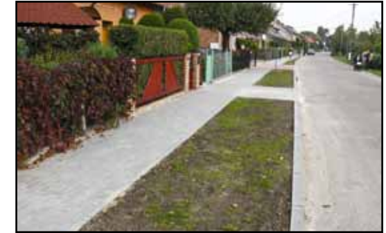
Wyremontowany chodnik przy drodze gminnej w miejscowości Rieczna.
