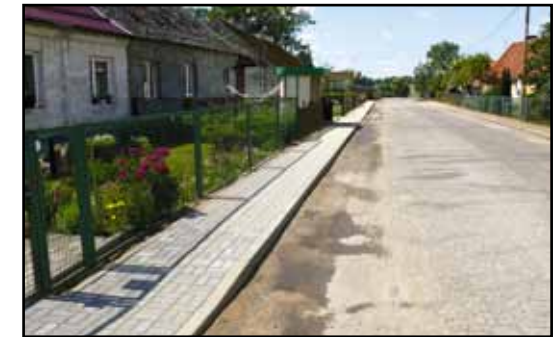
Wyremontowana nawierzchnia chodnika przy drodze powiatowej w miejscowości Dargowo.
