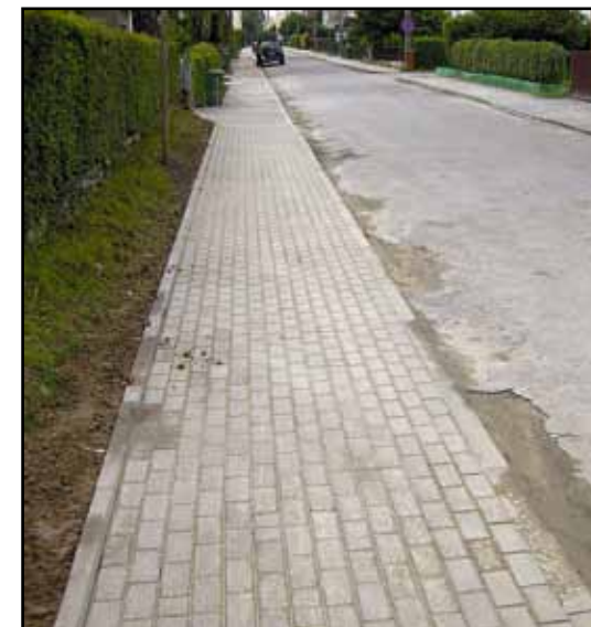
Chodnik przy powiatowej ulicy Limanowskiego w Pasłęku po wykonaniu remontu.
