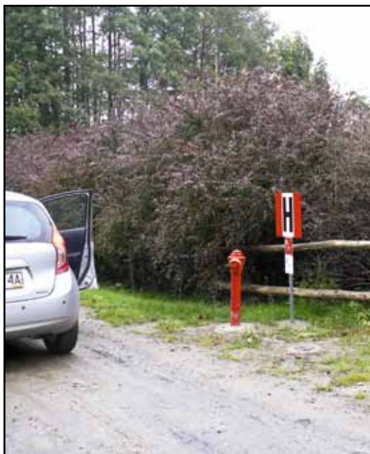
Wodociąg Kol. Zielonka.
