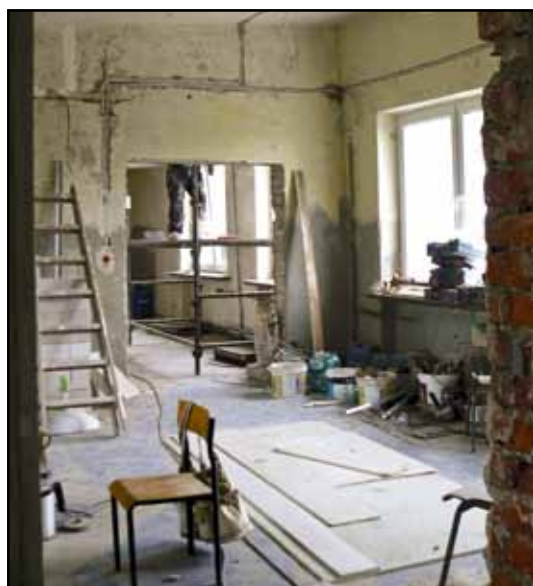
W trakcie remontu.
