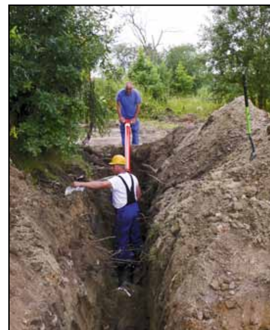
Budowa sieci wodociągowej Awajki.
