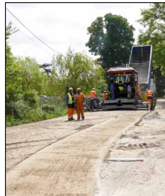
Budowa drogi gminnej Gulbity – Anglity.
