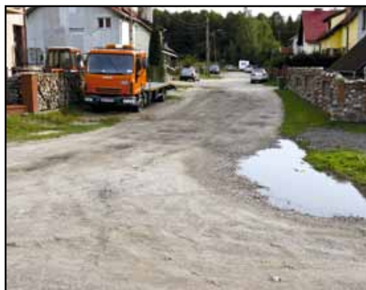
Ul. Gen. Andersa przed budową.
