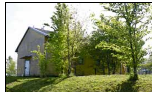
Budynek stacji uzdatniania wody przed remontem.
