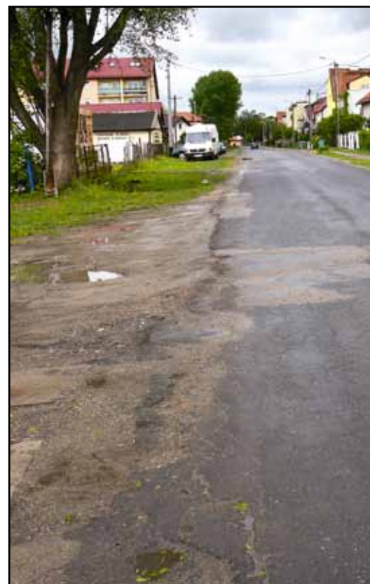
Ul. Polna w Pasłęku przed przebudową.
