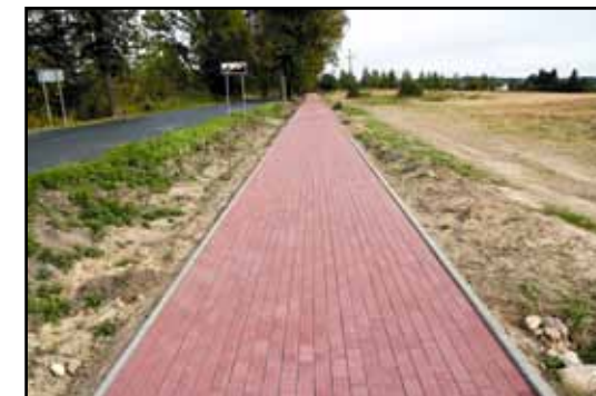
Wybudowany ciąg pieszo-rowerowy w pasie drogi wojewódzkiej nr 527 na odcinku Pasłęk – Rzędy, etap III.
