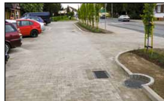
Wyremontowany parking przy ul. Jagiełły.
