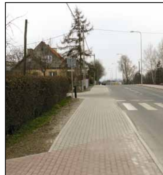
Ul. Polna w Pasłęku po zakończeniu inwestycji.
