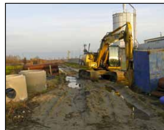
Ul. Firmowa w realizacji.
