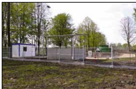
Oczyszczalnia ścieków w Kwitajnach.
