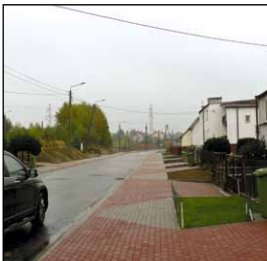
Ul. Długa po zakończeniu prac.
