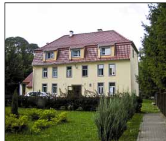
Zabytkowa kamienica przy ul. Boh. Westerplatte po remoncie.
