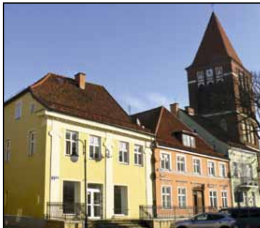
Budynki przy ul. Bolesława Chrobrego planowane do podłączenia do sieci ciepłowniczej w 2018 roku.
