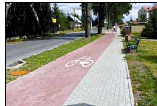
Wybudowany chodnik i ścieżka rowerowa w pasie drogi wojewódzkiej nr 527 na odcinku Pasłęk – Rzędy etap II – od skrzyżowania z ulicą Ogrodową do skrzyżowania z ulicą 3 Maja.
