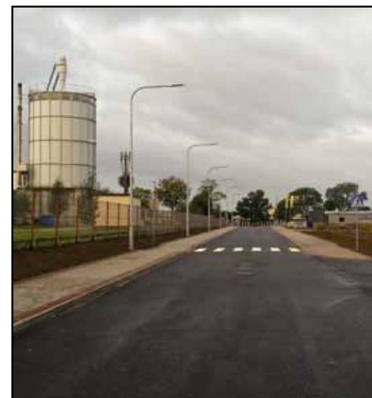
Ul. Firmowa - po zakończeniu robót.
