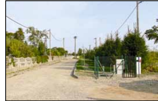
Kanalizacja z przepompownią ścieków – ul. Kopernika, po zakończeniu robót.
