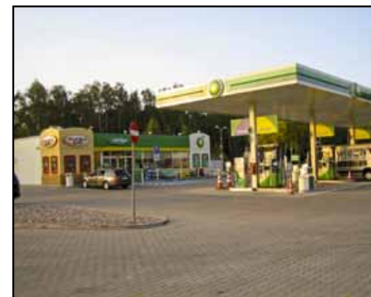
Budowa stacji paliw BP przy drodze S7 w obr. Zielony Grąd.
