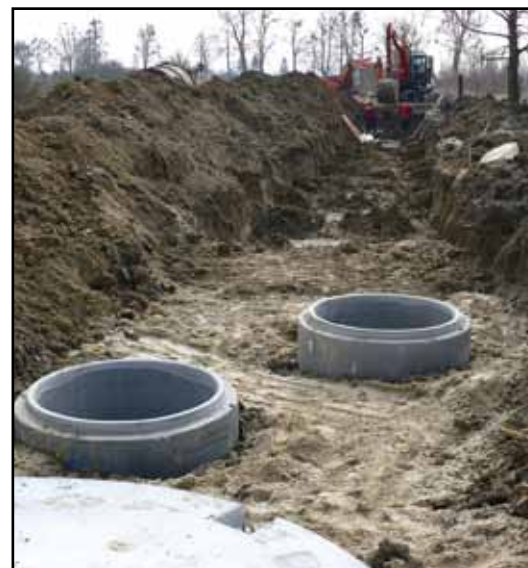
Uzbrojenie terenów przy ul. Kopernika w trakcie robót.
