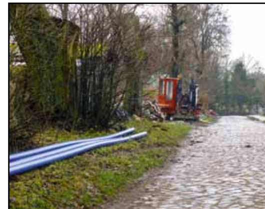
Budowa wodociągu Drulity – Sokoły.
