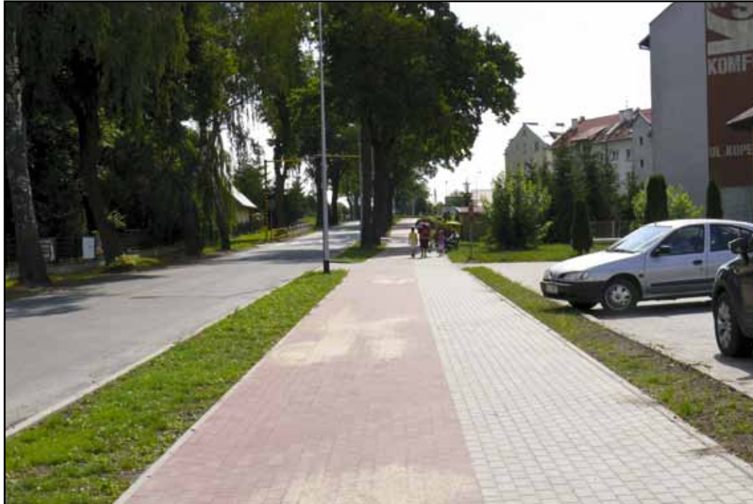
Chodnik przy ul. Kopernika po zakończeniu inwestycji.
