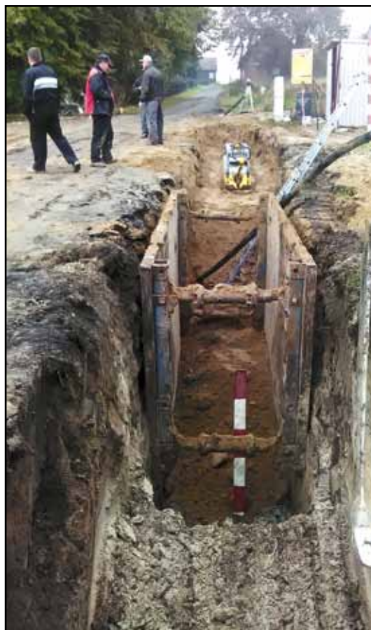
Kanalizacja, ul. Kolonia Zdroje, w trakcie prac.
