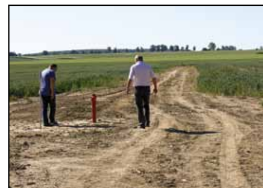
Wykonany odcinek sieci wodociągowej dla nowego zakładu przy ul. Dworcowej.
