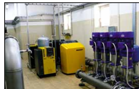
Zestaw pompowy i sprężarka po remoncie.
