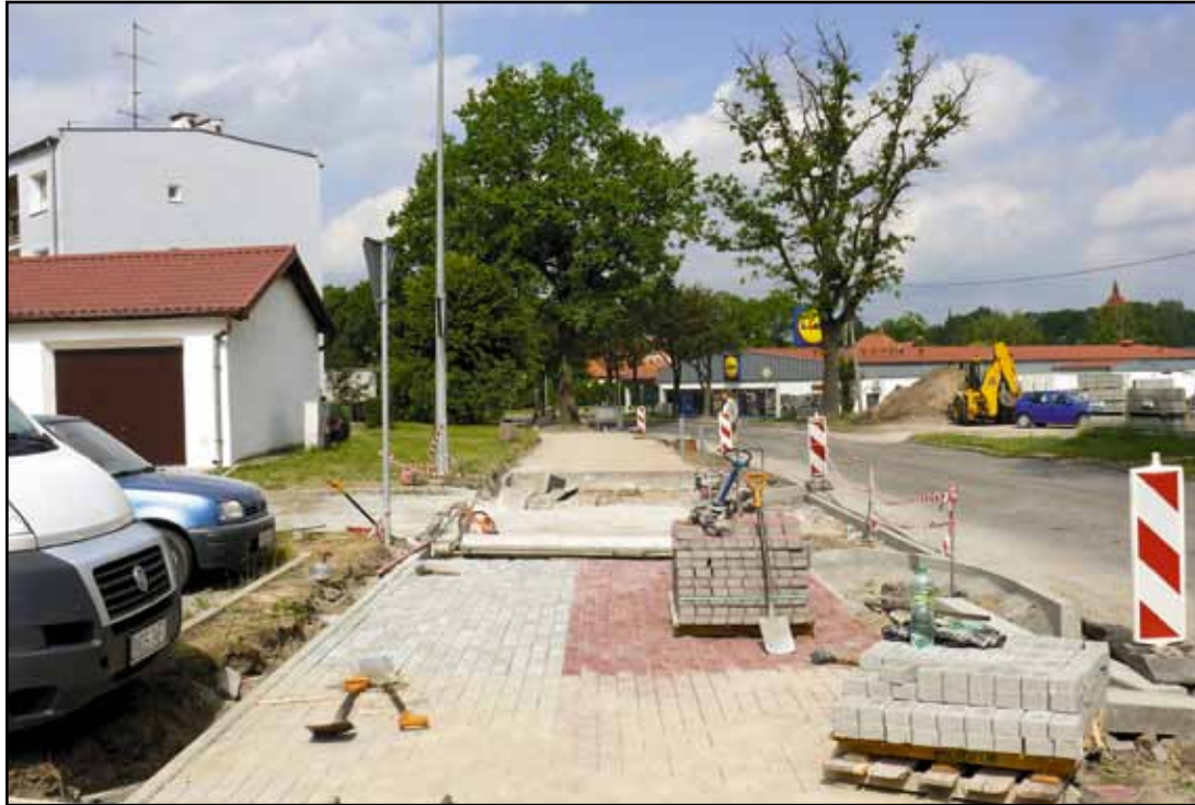
Chodnik przy ul. Kopernika w trakcie robót.
