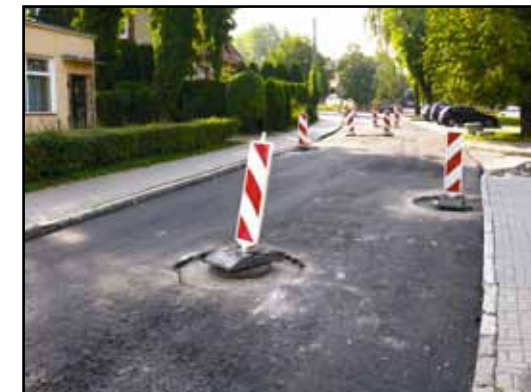
Remont nawierzchni ul. Bankowej.
