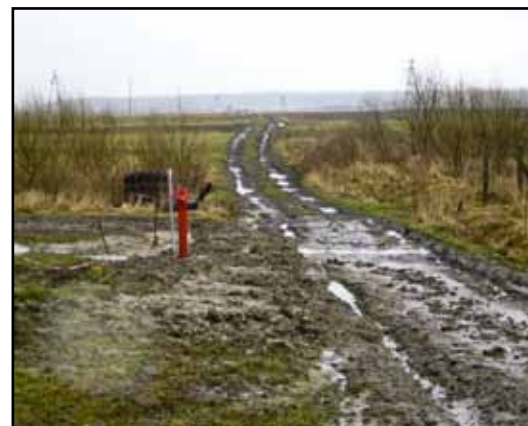
Rozbudowa sieci wodociągowej w Rogajnach.
