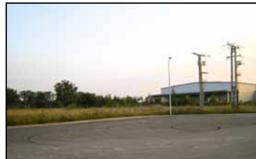
Teren lokalizacji budowy 2 hal produkcyjnych S-ki DRE w Pasłęku przy ul. Firmowej.
