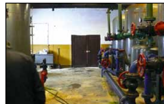
Stacja uzdatniania wody Krasin przed remontem.
