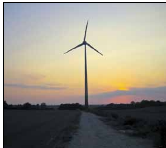
Budowa elektrowni wiatrowej w Krasinie.
