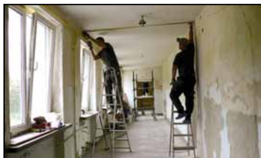
Remont instalacji elektrycznej na piętrze.
