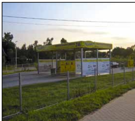
Budowa samoobsługowej myjni samochodowej w Krośnie.
