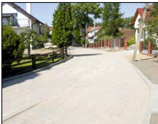
Wyremontowana ulica Witosa w Pasłęku.
