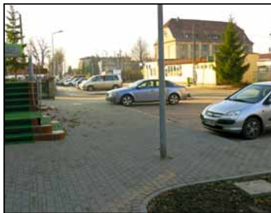
Wyremontowany chodnik przy powiatowej ulicy Dworcowej - etap II - odcinek od przejazdu kolejowego do skrzyżowania z ulicą Bohaterów Westerplatte.
