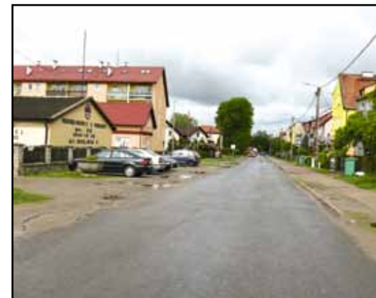
Ul. Polna w Pasłęku przed przebudową.
