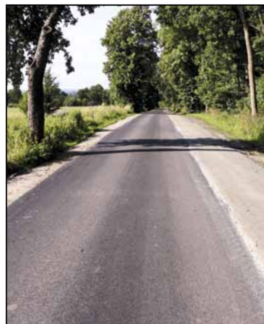
Wyremontowana nawierzchnia drogi powiatowej nr 1135N od miejscowości Aniołowo do przejazdu PKP o długości 0,9 km.
